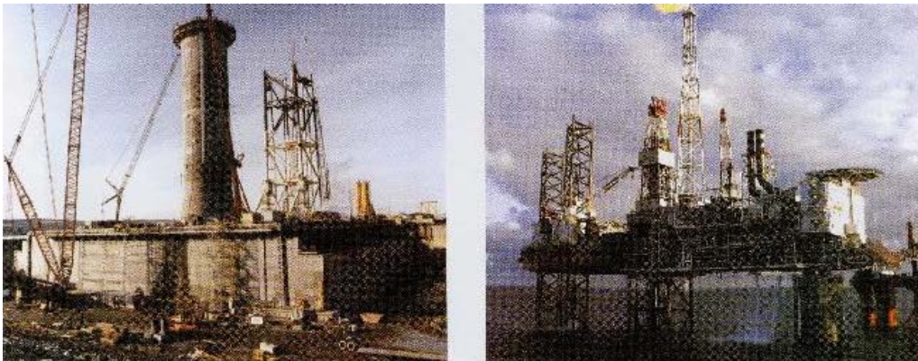
Figura 8 : Aspecto da construção e da utilização de uma plataforma petrolífera, construída, no mar do norte, em betão leve
